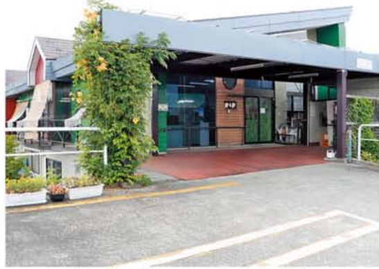
ケアセンター「ハーモニー」建物
