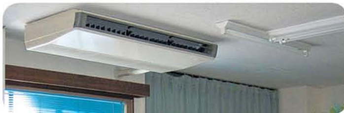
多目的室に天吊り型エアコン設置
