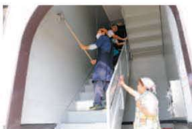
外階段・外壁そうじ
