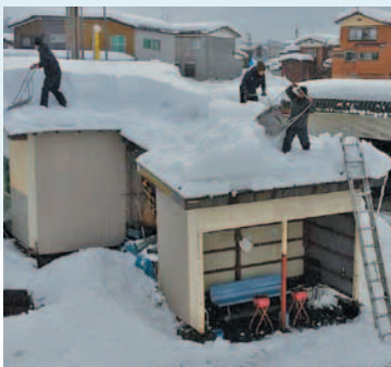
ワーク施設の屋根雪下し
