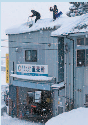
ワークセンター棟の雪下し
