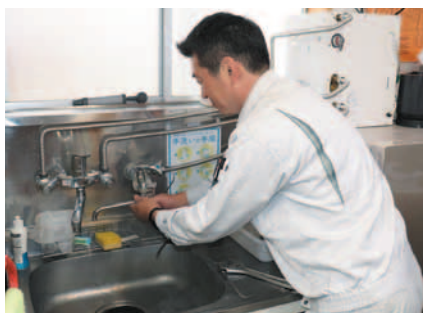
水回りを修繕する樋口社長
