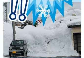
屋根の高さまで達した雪壁
