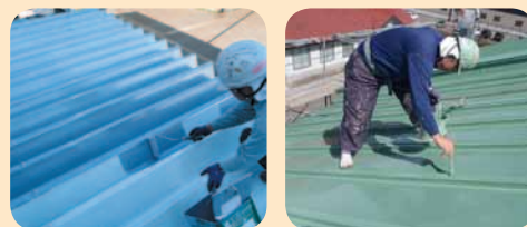
屋根・壁の 塗装作業
